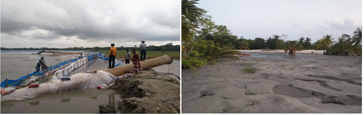
চিত্রঃ DYKE PROTECTION WORK.
